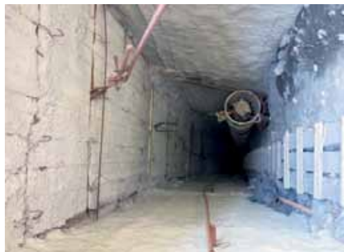
Вентиляционная шахта подземного рудника
